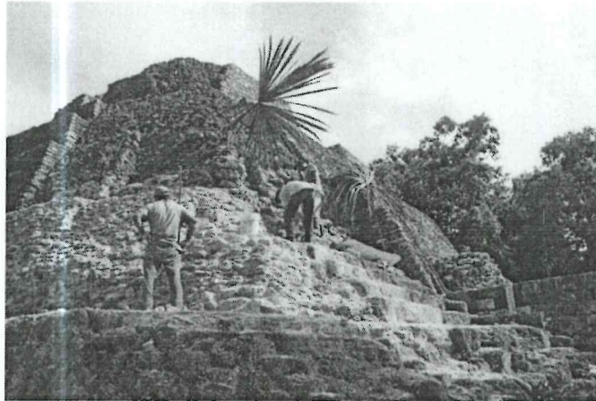
Foto 6. Edificio 137, Acrópolis Norte durante los trabajos
