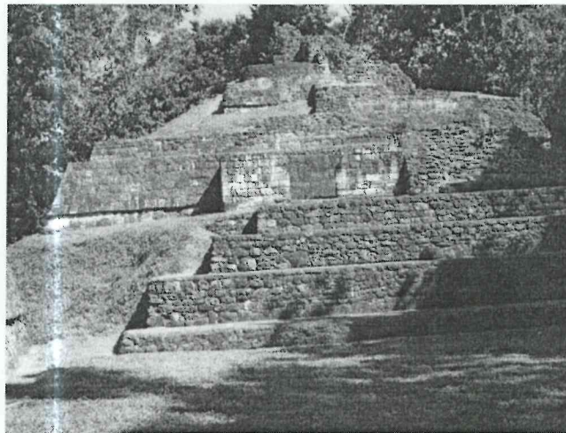
Foto 1. Edificio 6, Grupo Maler
